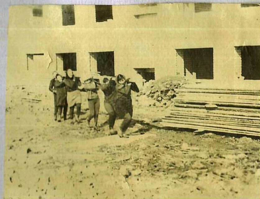
КОММУНИСТИЧЕСКИЙ СУББОТНИК. ПОМОГАЕМ СТРОИТЬ СПТУ-20
